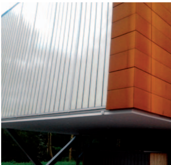
Een balvast uitgevoerde gevel met verticale structuur in een sporthal
